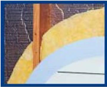
본 시공법은 기존 부피단열재와 폴리늄이 함께 시공되어 더욱 큰 R-value of R- 19.56를 얻어내고자 하는 것이다. 이 시공법은 폴리늄 단열재와 부피 단열재 그리고 경질판(Rigid board)으로 구성되어 있다. 이 조립법은 골격 설치 비용을 감소시키는 한편 아주 높은 단열규정을 요구하는 건축법을 만족시키기 위해 개발되었다.
