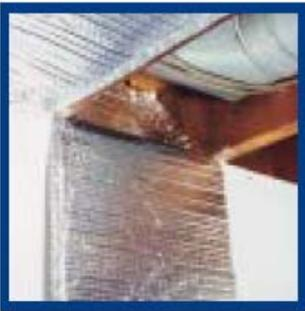
폴리늄을 바닥아래 공간에 설치할 경우 겨울철 콘크리트 아래로 뺏기던 열이 위로 반사 되어 97%의 열이 집안으로 되돌려집니다. 발을 시렵게 하던 겨울철 차가운 바닥의 온도는 자연스럽게 올라가고 연료비는 절감되며, 더 나은 쾌적함을 제공합니다.
